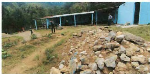
Foto 3: Ampliación del patio de la cocina, cambio de láminas por láminas troqueladas y colocación de piso cerámico.
