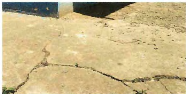
Foto 1: Cambio de piso de torta por cerámico del corredor de la cocina.
