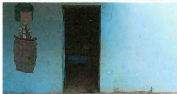
Foto 4: ampliación de puerta y cambio de puerta
