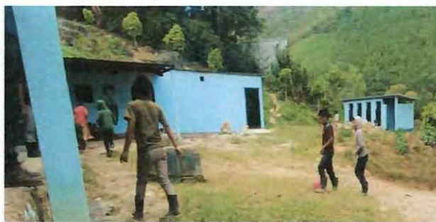
Foto 6: Cambio de láminas de baño a láminas troqueladas
