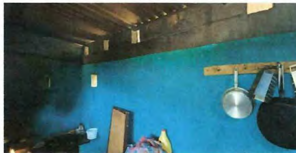
Foto 2: ampliación de altura y del ancho de la cocina.
